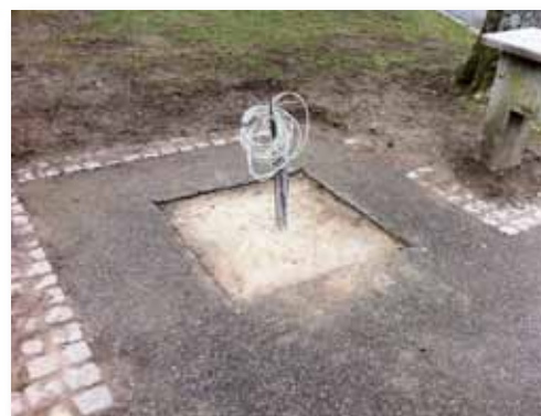
Installation des cables et du socle
